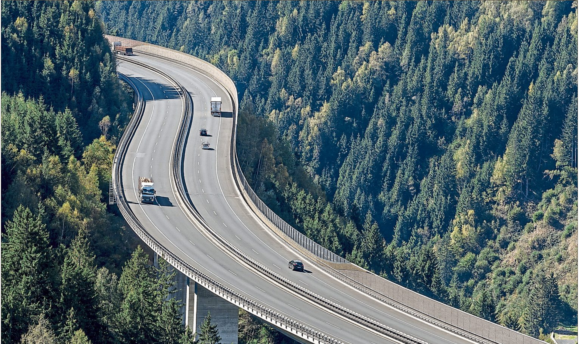
Eine einzelne Brücke kann, wenn sie für den Verkehr ganz oder teilweise gesperrt wird, eine ganze Verkehrsbeziehung stören oder gar unterbinden.
