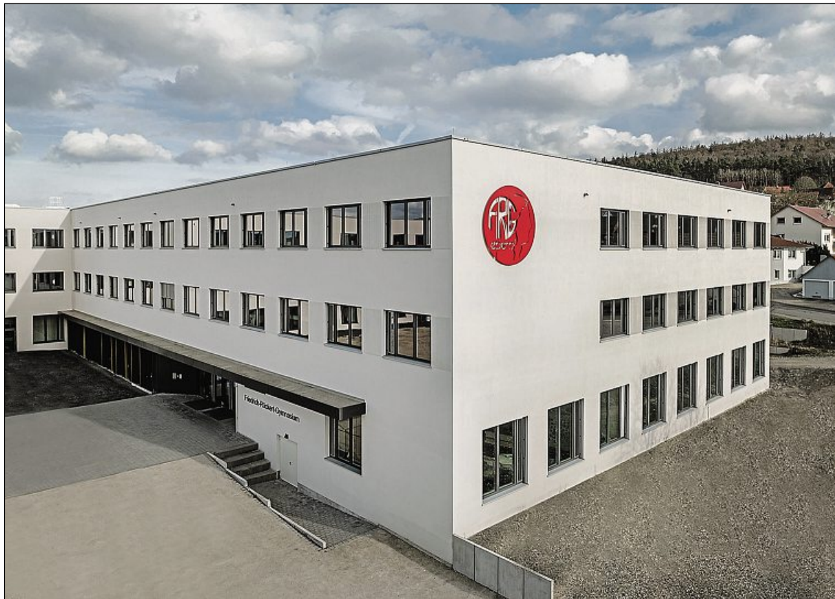
Entstanden ist eine hochmoderne Schule.
