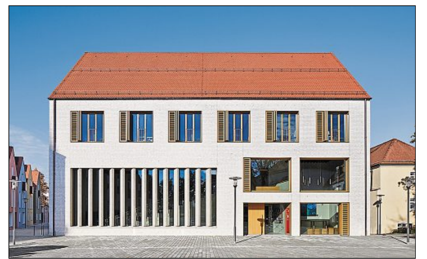
Der mit Klinker verkleidete Gebäudeteil vom Residenzplatz aus gesehen.
