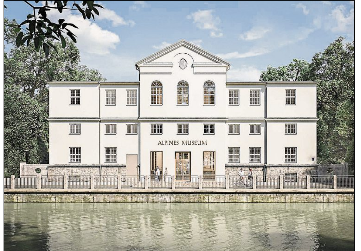
Die neue Fassade mit dem Eingang zur Straßenseite hin.
