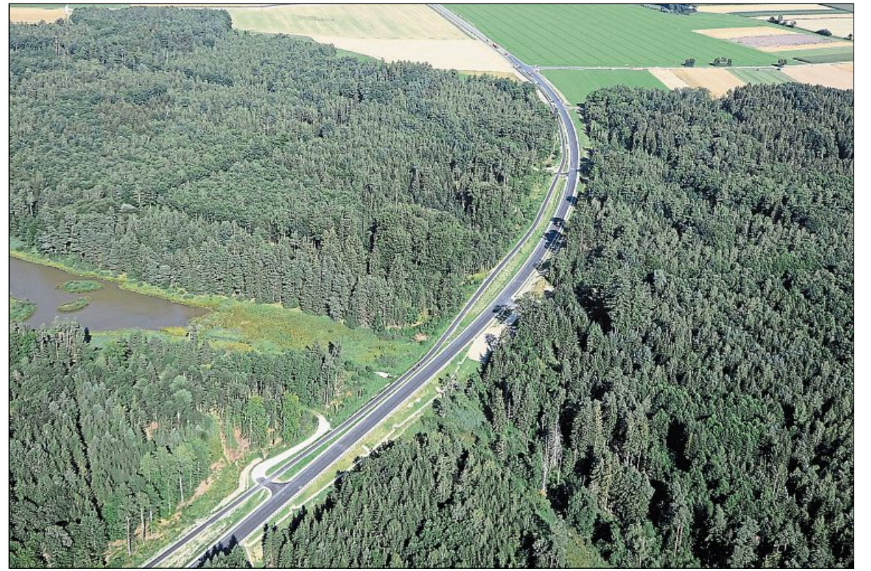
Die fertiggestellte Strecke zwischen Deisenhausen und Ingstetten.
