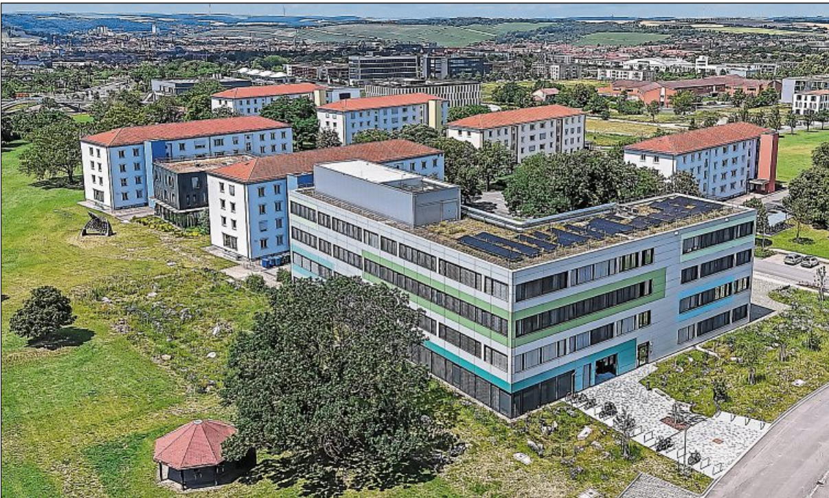
Der Neubau des KI-Gebäudes aus der Luft gesehen.
