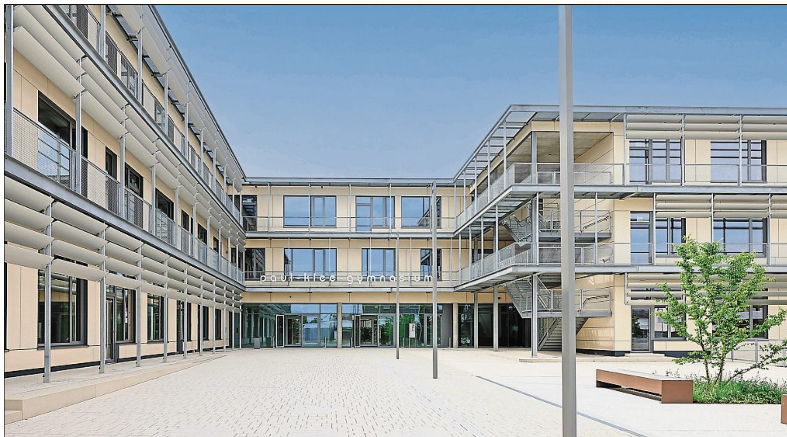
Der Eingangsbereich des neuen Paul-Klee-Gymnasiums in Gersthofen.
