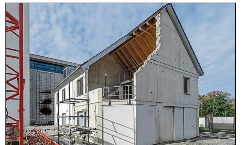
Eine Außenbrandstelle auf dem Übungsgelände und ein Doppelhaus mit fertiggestellter Wohnhaushälfte und Trümmerhaus.
