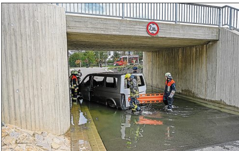
Überflutungsszenario an der Unterführung.
