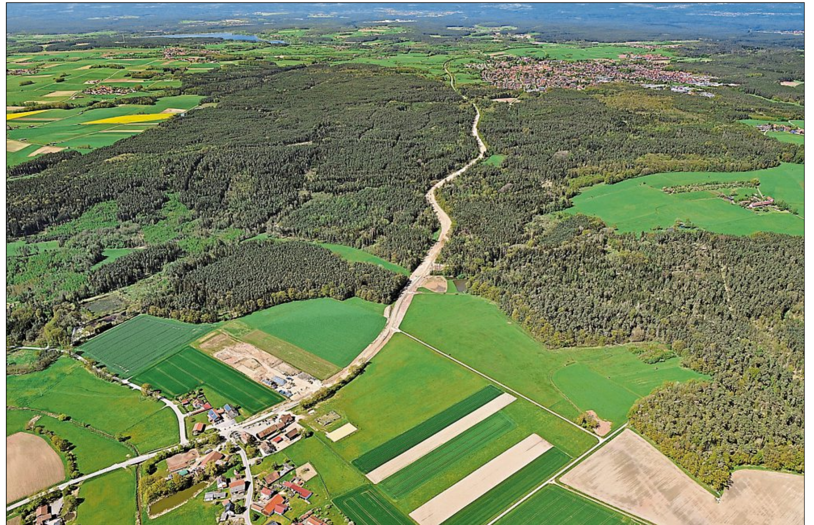
Die Strecke während des Erdbaus.
