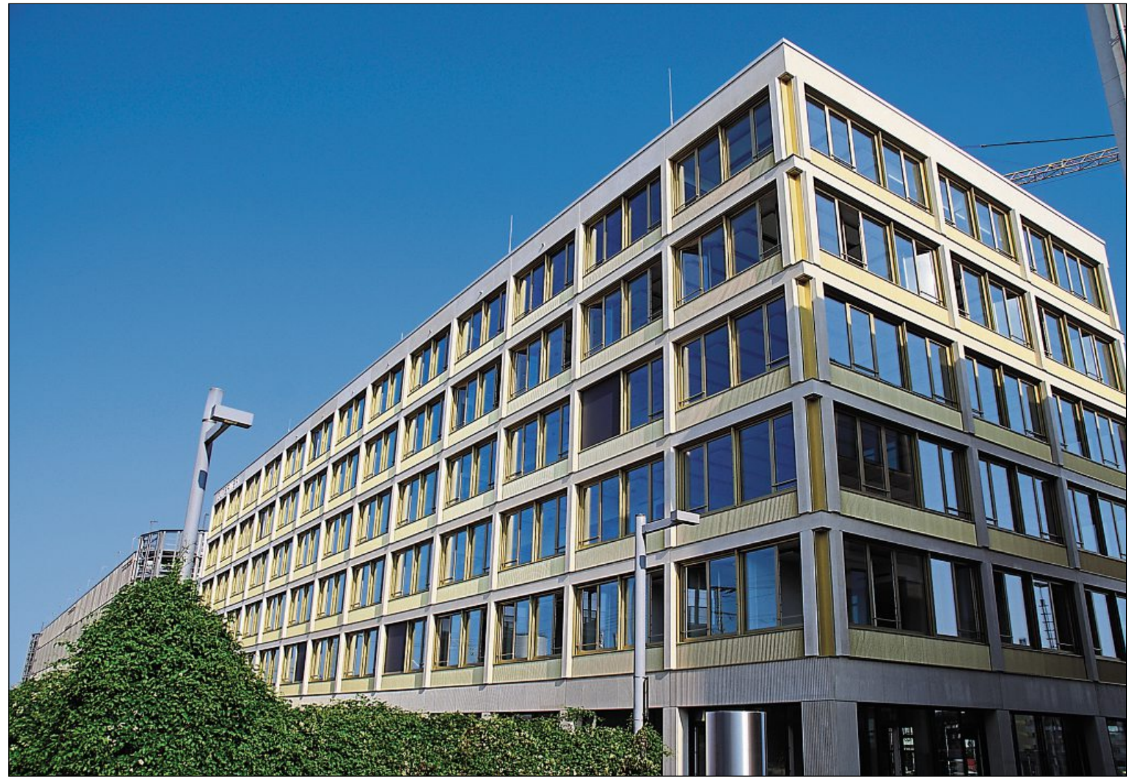
Brüstungsverkleidungen aus bronzefarbenem Profilblech verleihen dem Gebäude eine facettenreiche Gestalt.
