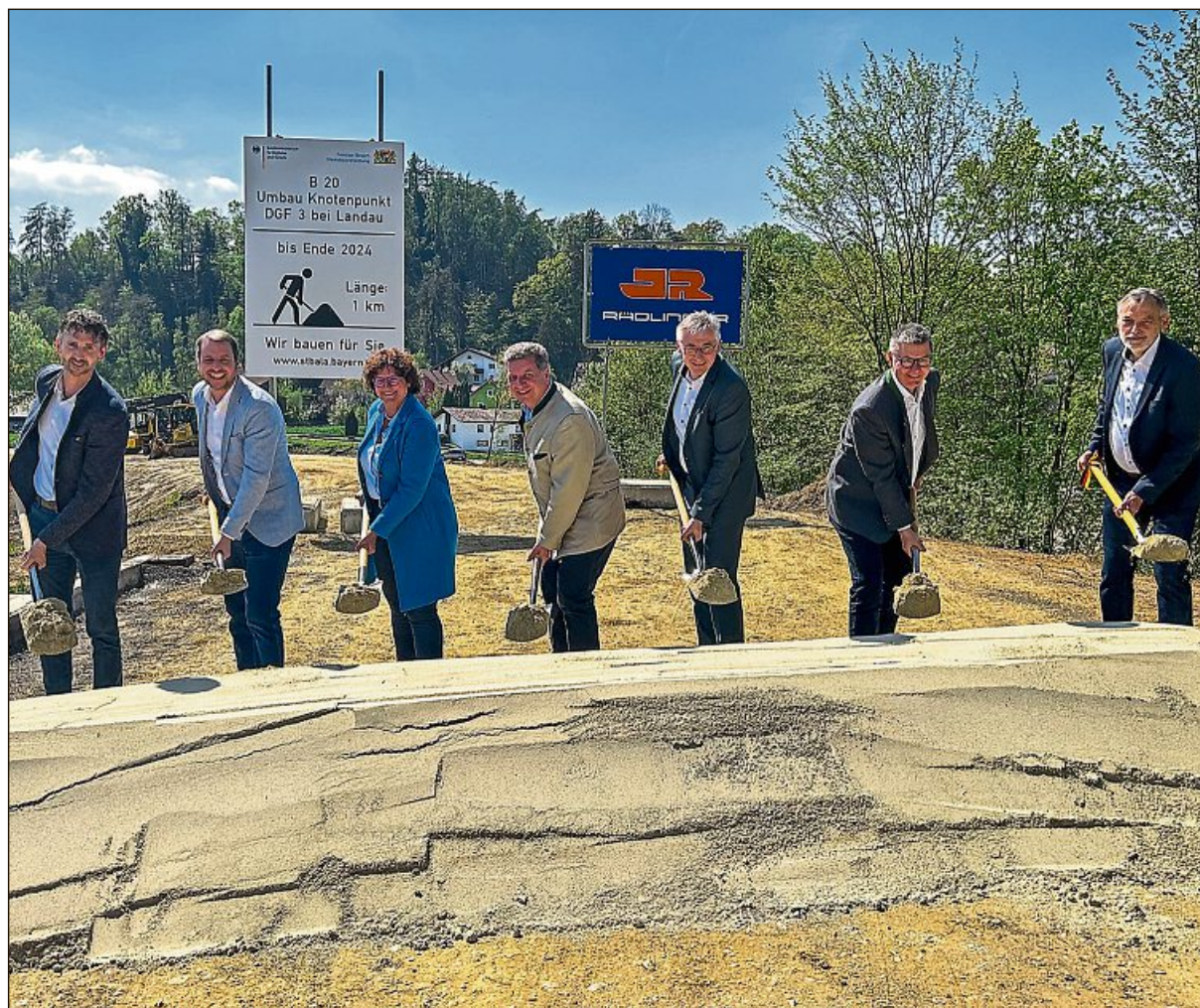
Bau- und Verkehrsminister Christian Bernreiter (vierter von links) beim Spatenstich für einen Kreuzungsombau in Landau an der Isar. FOTO: STMB
