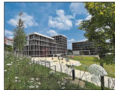
Blick aus Südwesten auf den Neubau. FOTO: THORSTEN GUTSCHE
