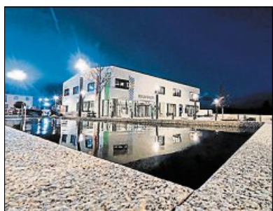
Das neue Rathaus und der neugestaltete Platz davor. FOTO: ALEX FISCHL
