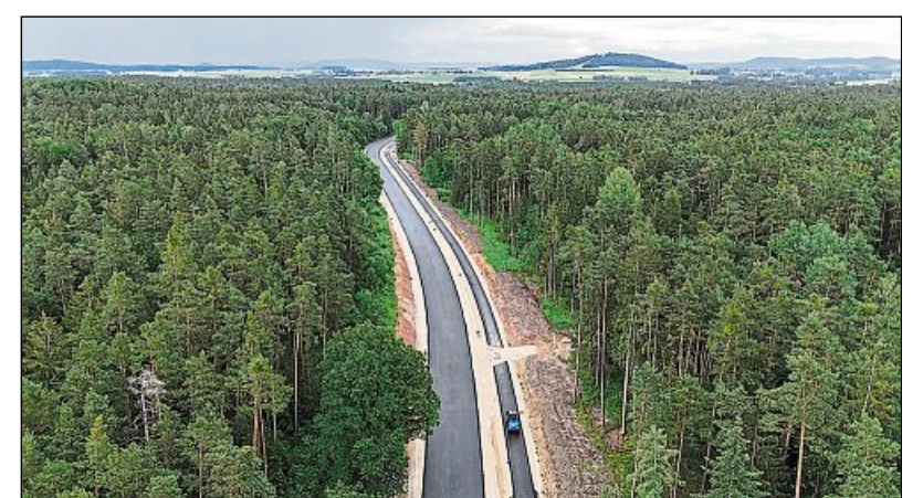
Der Asphaltbau und die geteerte Strecke. FOTOS: STAATL. BAUAMT NÜRNBERG
