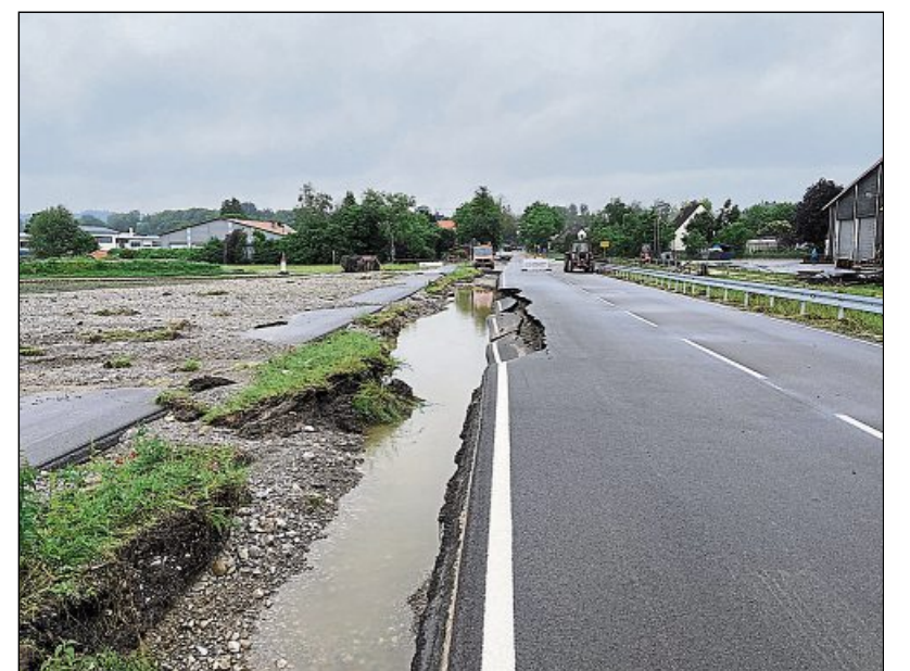
Das Hochwasser Anfang Juni verzögerte die Verkehrsfreigabe.
