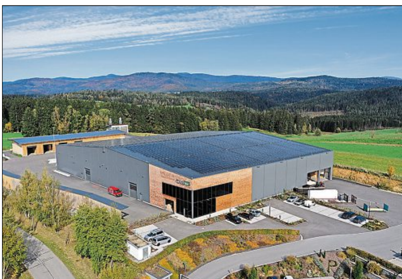
Die Holznägel. Die Produktionshalle im niederbayerischen Regen ist eine der größten Produktionshallen, die bisher in Niederbayern in Holzmassivbauweise errichtet wurden.
