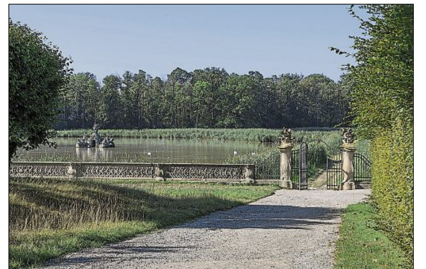
Auch die Gartenmauern wurden saniert.
